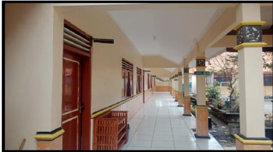
Gambar 8. Rehab Ruang Kelas SDN Gunungpring 3 Muntilan
